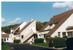
I.M.A. du Pays de Montereau Château de Courbeton 77130 ST GERMAIN LAVAL
